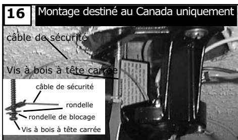
16 Montage destiné au Canada uniquement Pour le montage destiné au Canada, que ce soit selon la méthode de suspension encastrée ou selon la méthode de la tige verticale, le câble de sécurité doit être installé dans les poutres de la charpente du bâtiment à l'aide des rondelle, rondelle de blocage, vis à bois à tête carrée de 7,62 cm fournies à cet effet. Assurez-vous que lorsque le câble de sécurité est entièrement déplié, les fils de connexion sont plus longs que le câble et qu'ils ne sont soumis à aucun effort de tension.
