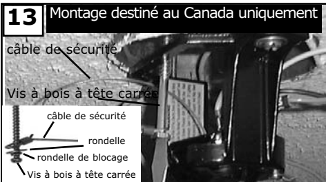
13 Montage destiné au Canada uniquement Pour le montage destiné au Canada, que ce soit selon la méthode de suspension encastree ou selon la méthode de la tige verticale, le câble de sécurité doit être installé dans les poutres de la charpente du bâtiment à l'aide des rondelle, rondelle de blocage, vis à bois à tête carrée de 7,62 cm fournies à cet effet. Assurez-vous que lorsque le câble de sécurité est entièrement déplié, les fils de connexion sont plus longs que le câble et qu'ils ne sont soumis à aucun effort de tension.
