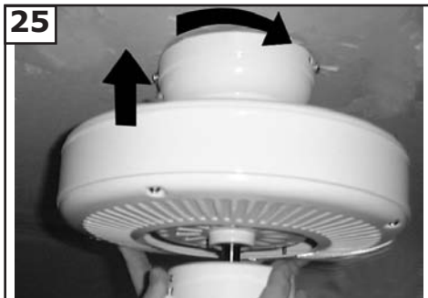
25 Prenez le support de suspension, et alignez les trous en forme de « L » avec les vis situées sur le support de suspension. Faites pivoter le support dans le sens des aiguilles d'une montre pour le mettre en position bloquée. Remettez en place les vis que vous avez retirées à l'étape précédente et serrez à fond. Installez les deux (2) autres vis fournies dans le paquet de quincaillerie et serrez à fond les quatre (4) vis.
