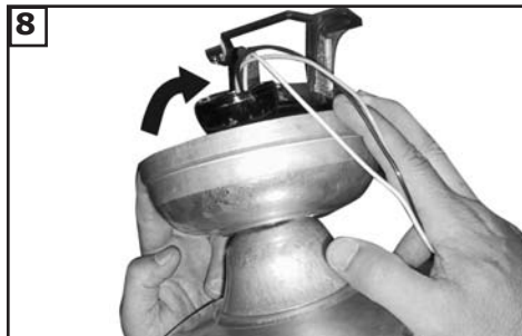
8 Suspendez le ventilateur monté depuis le support de suspension installé au plafond à l'étape précédente. Assurez-vous que le ventilateur est bien droit. Faites pivoter le ventilateur jusqu'à ce que la languette du support de suspension s'engage dans la fente de la rotule de la tige verticale. Ceci empêche le bâti du ventilateur de pivoter lorsque les lames sont en mouvement.
