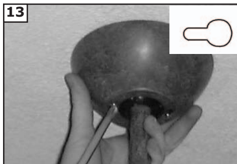
13 Installez la garniture au plafond et alignez les trous piriformes avec les vis sur la partie inférieure du support de suspension. Faites pivoter la garniture dans le sens contraire des aiguilles d'une montre pour la mettre en position de blocage. Serrez les vis pour fixer la garniture. Voir l'encart relatif à la forme des trous piriformes.
