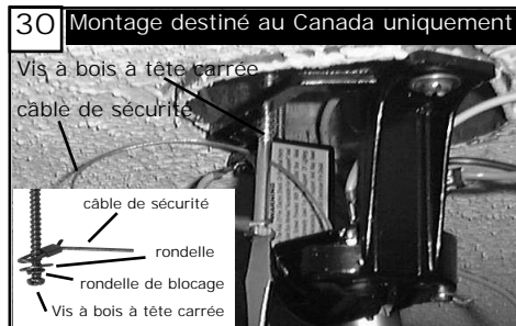
30 Pour le montage destiné au Canada, que ce soit selon la méthode de suspension encastrée ou selon la méthode de la tige verticale, le câble de sécurité doit être installé dans les poutres de la charpente du bâtiment à l'aide des vis à bois à tête carrée de 7,62 cm fournies à cet effet. Assurez-vous que lorsque le câble de sécurité est entièrement déplié, les fils de connexion sont plus longs que le câble et qu'ils ne sont soumis à aucun effort de tension.
