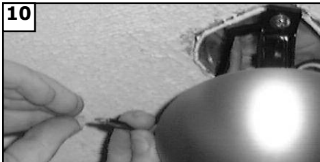
10 Établissez les rapports de fil à la source d'énergie utilisant des écrous de fil fournis. Assurez-vous qu'aucun filaments n'est en dehors de du wirenut. Après avoir établi les rapports de fil, les fils devraient être répan- dus à part avec le conducteur fondé et le conducteur équipement-fondant d'un côté de la boîte de sortie et le conducteur sans mise à la terre de l'autre côté de la boîte de sortie. Des fils épissés devraient être tournés vers le haut et poussés soigneusement vers le haut dans la boîte de sortie.
